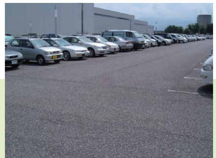
雨水浸透アスファルト( 駐車場 )
