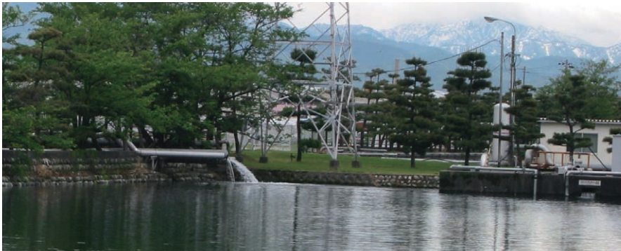
側面が石積みで浸透性を持つ冷却水回収池
