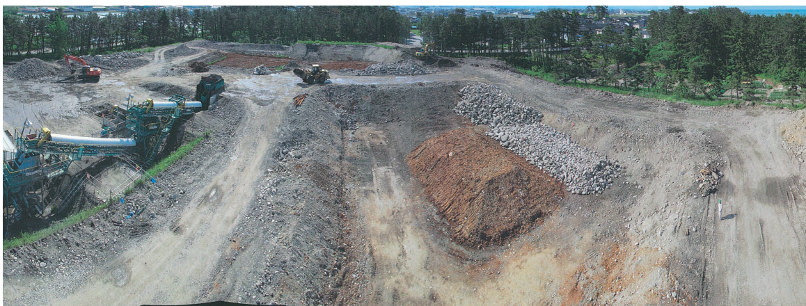
廃棄物最終処分場の解体・更地化
