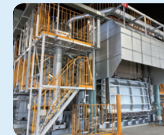
四国製造所 アルミ溶解炉
